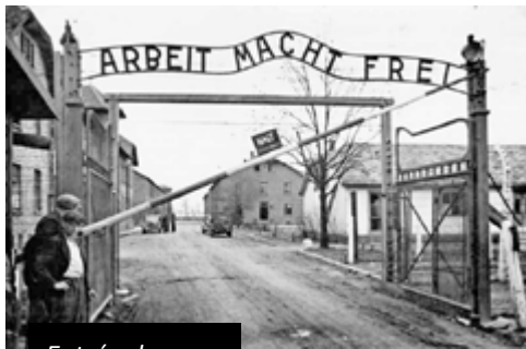
Entrée du camp
